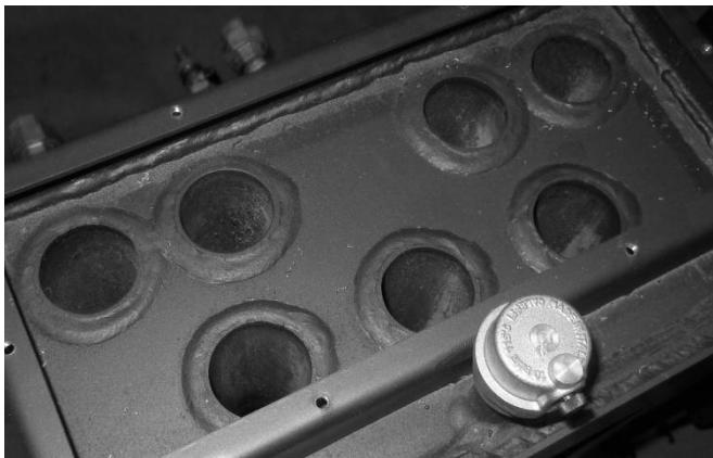
Izgled peći kada se otvori revizionni poklopac kotla.
